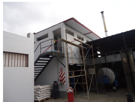
Vestuarios – Laive S.A.
