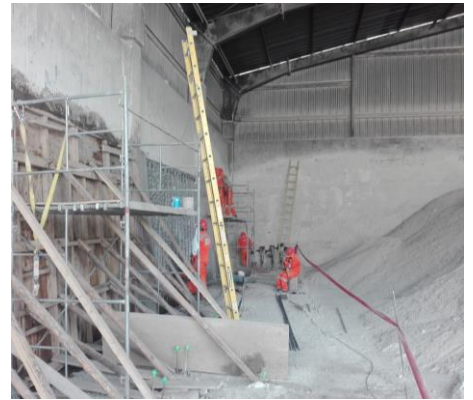
Reparación de Muros en Almacén
