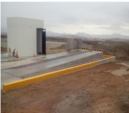
Lavado Maquinaria y Vehículos Inkabor SAC
