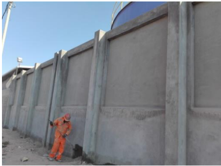
Eliminación de Salitre de Muros.
