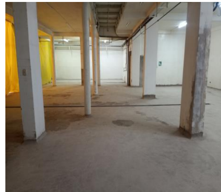
Losa de Concreto Armado. Envasadora Majes E.I.R.L.
