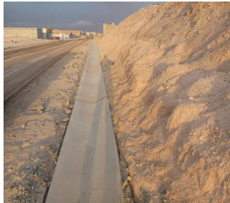
Cuneta Challapampa - Inkabor SAC
