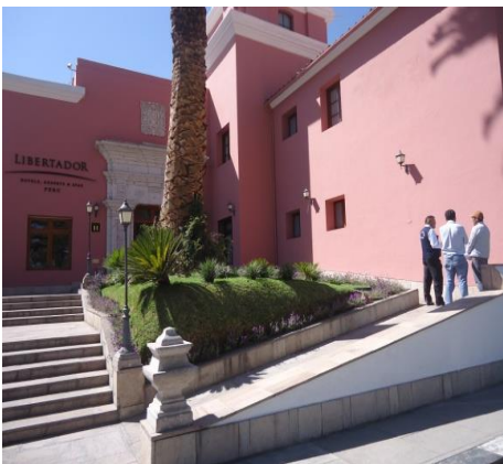
Pintura Industrial – Hotel Libertador
