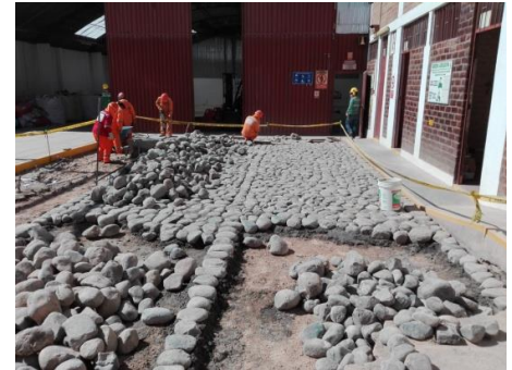
Emboquillado, Empedrado - PROTISA
