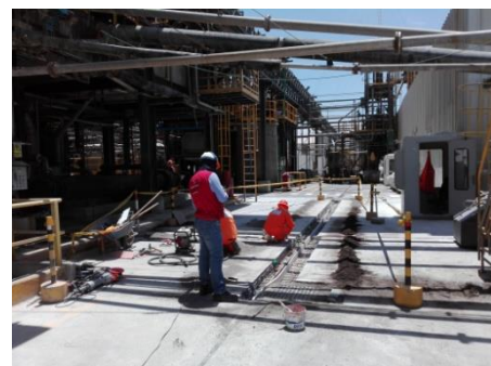
Reparación Juntas de Dilatación.
