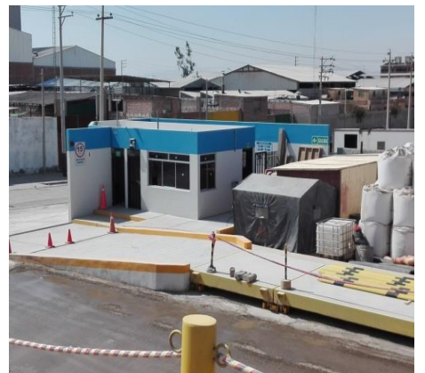
Vigilancia, Oficinas, Sala Tableros
