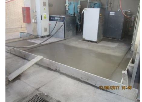
Losas Industriales, Compresores.
